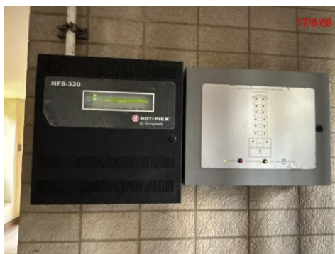
แผนควบคุมอุปกรณ์เตือนอัคคีภัย
